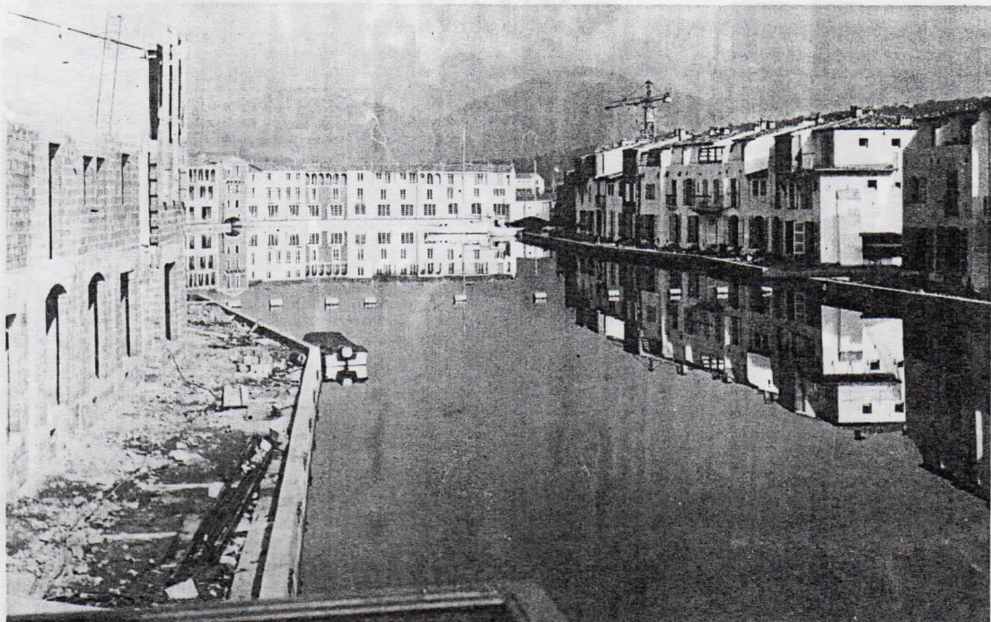
Grâce au beau temps que nous avons eu durant les trois mois d'automne, les travaux ont suivi la cadence escomptée. La 5 e tranche sera livrée à partir de janvier, la 7 e à partir de mai.
